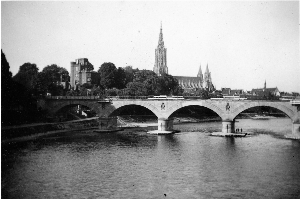
Blick auf die Eisenbahnbrücke und die Villa Wechsler, 1932 (StadtA Ulm, G 7/2.1 Nr. 00814)
