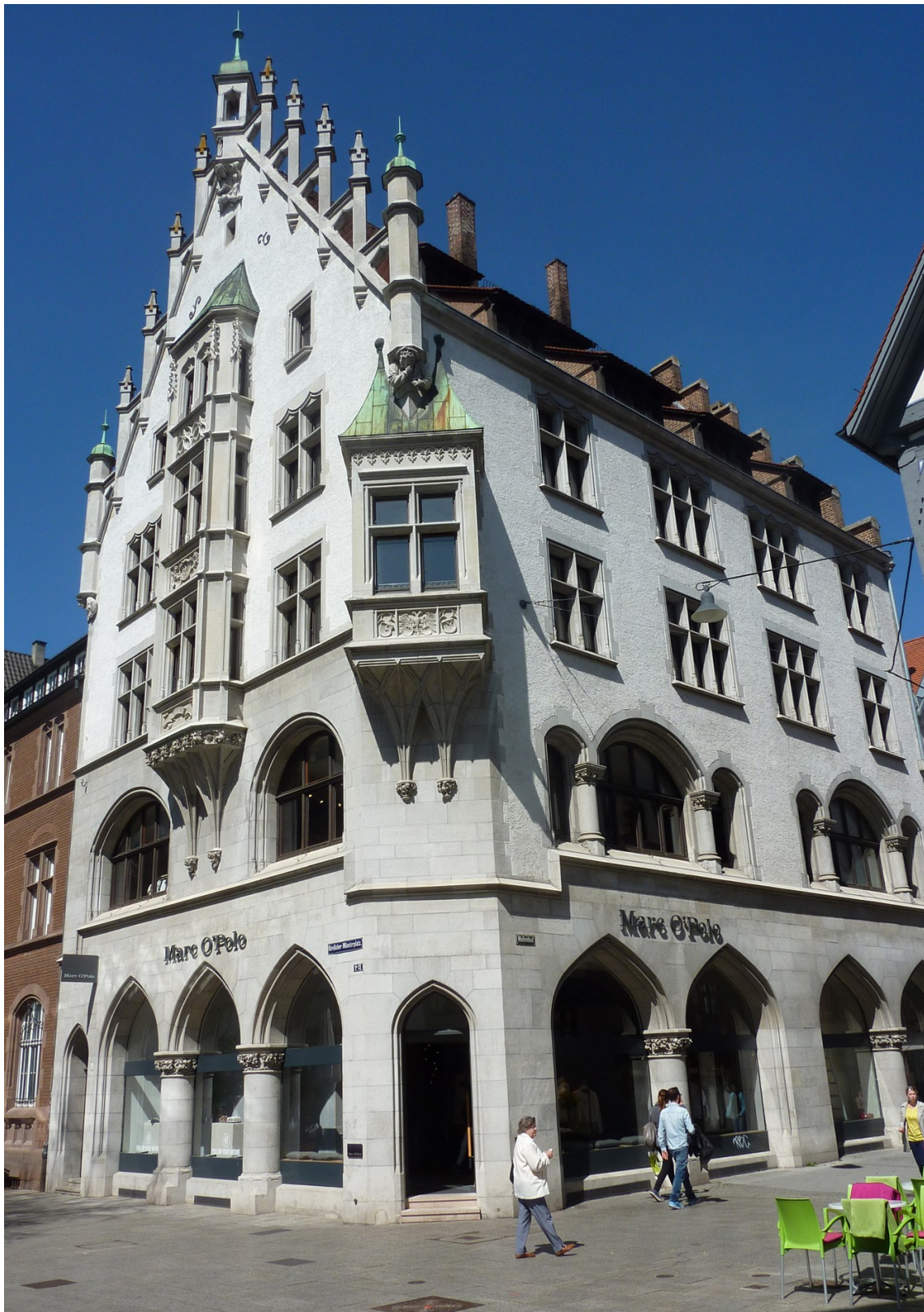
Haus der württembergischen Landesbank am Nördlichen Münsterplatz, 1899 gebaut mit Kunststeinelementen der Firma Leube (privates Foto)
