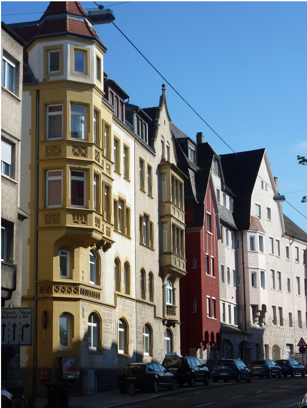
Häuserzeile in der Zinglerstraße gebaut mit Kunststeinelementen der Firma Schwenk (privates Foto)
