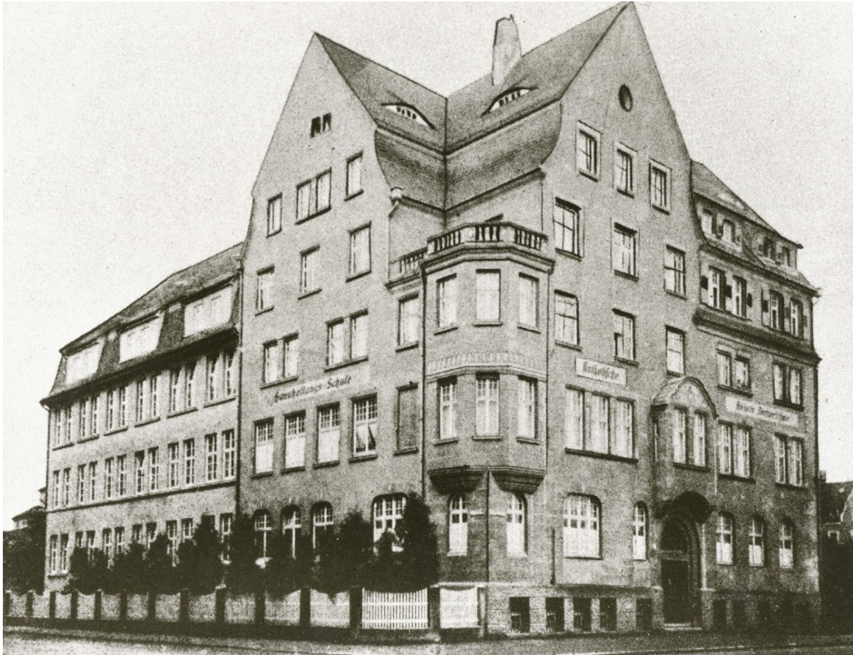
Schulgebäude St. Hildegard, Wagnerstraße 65, zuvor Gebäude des Reform-Pädagogium. Linker Gebäudeflügel nachträglicher Erweiterungsbau von 1926 für das Internat. (Privat Schwesternkonvent St. Hildegard)
