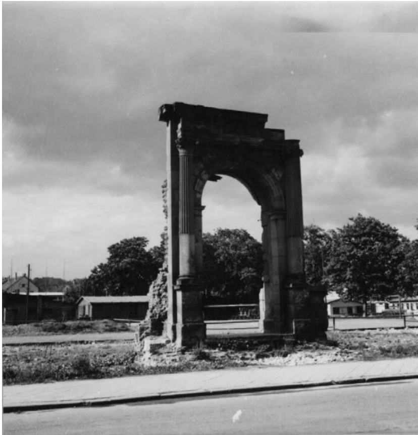
Ruine des Gymnasiums nach der Zerstörung. Auf dem Gelände sind Behelfsbaracken für den Unterricht an der Kepler-Oberschule aufgebaut (StadtA Ulm, G 7/2.2 Nr. 3581)
