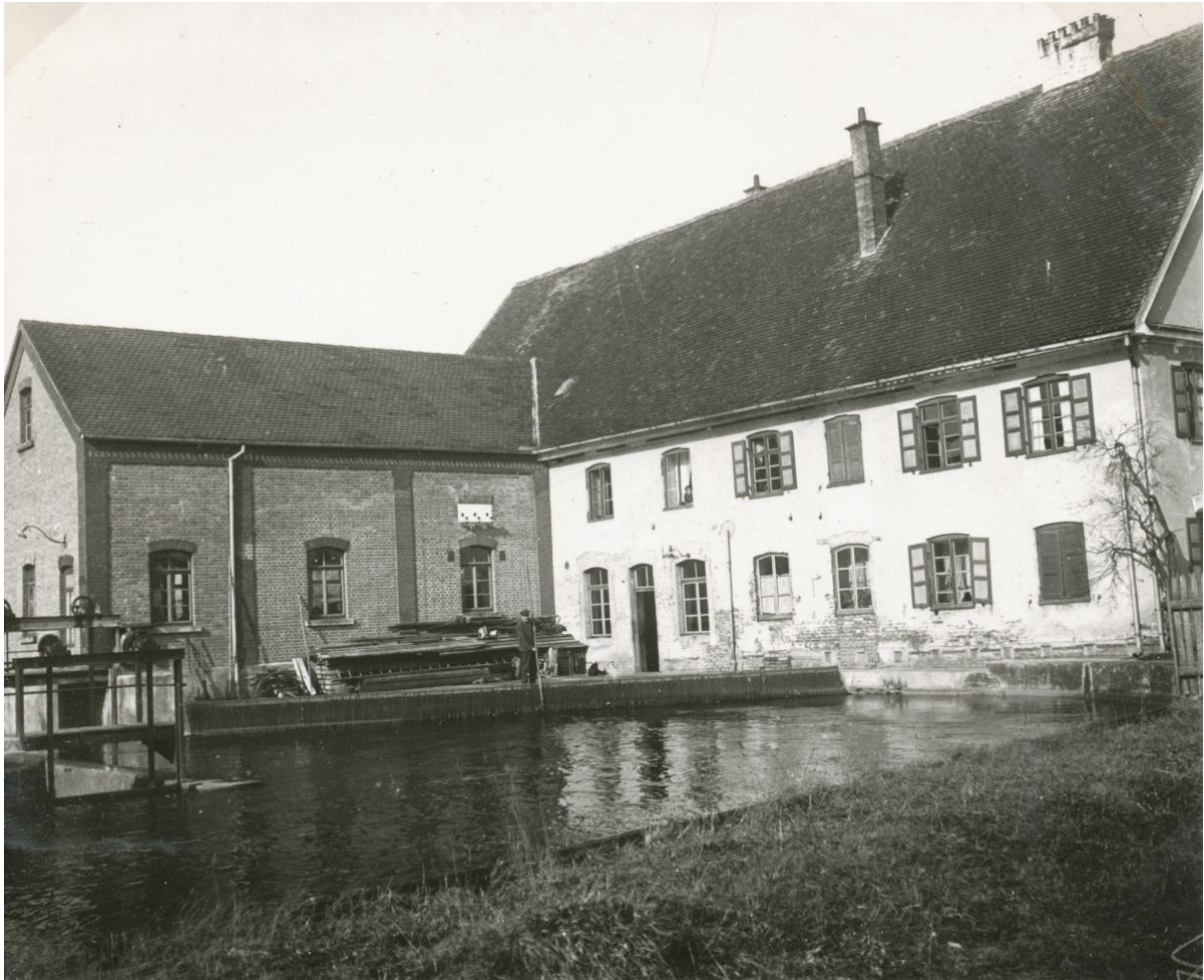
Kraftwerk Illerzell, um 1938 (StA Ulm, G 7/2.1)
