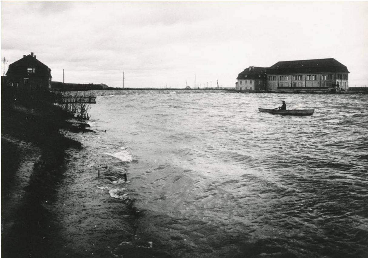
Kraftwerk Öpfingen mit Stausee, um 1925 (StA Ulm, G 7/2.1)
