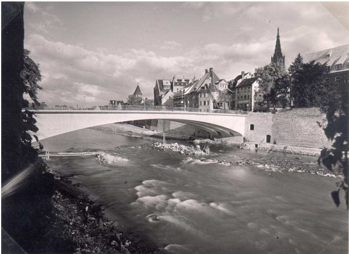
Blick auf die neue Herdbrücke (StA Ulm G 7/3.1 1949)
