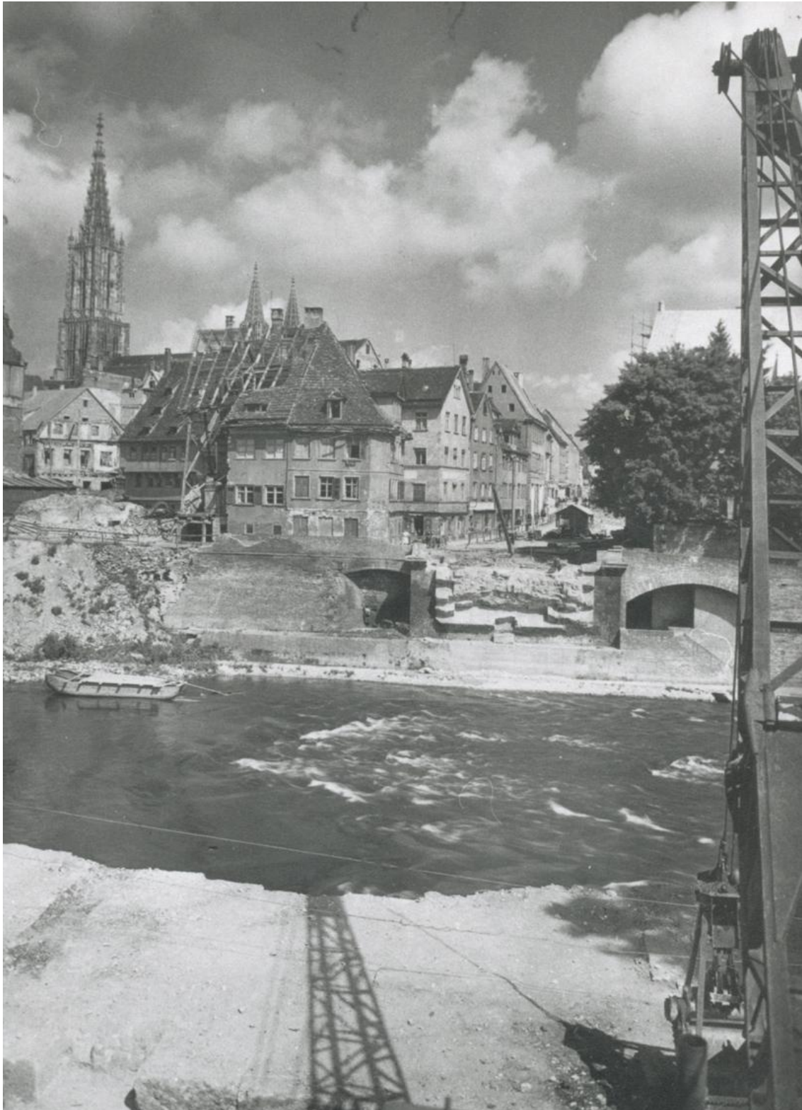
Zerstörte Herdbrücke vor dem Wiederaufbau 1947. (StA Ulm G 7/2.2 Donaufront)
