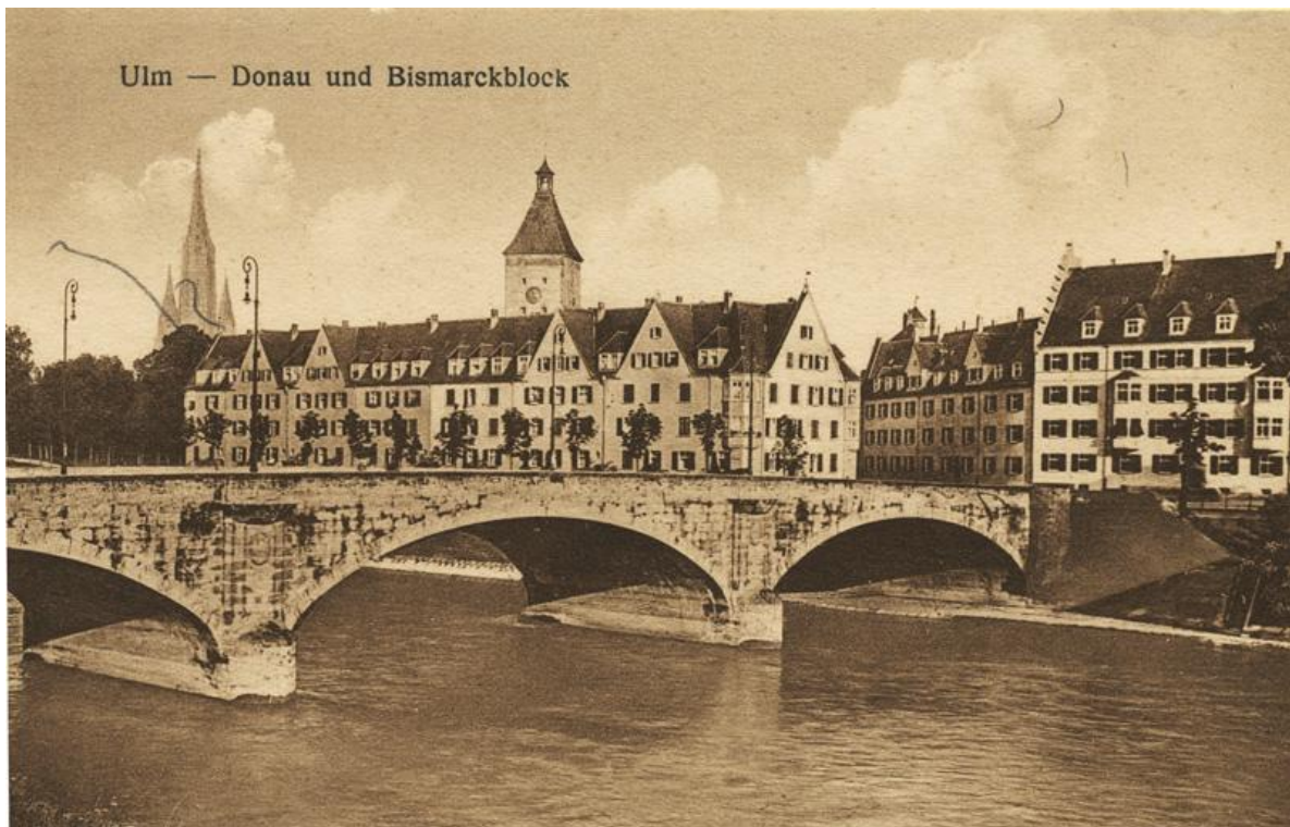
Neue Donaubrücke (Gänstorbrücke), 1912 (StA Ulm, G 7/2.1 Donaufront)
