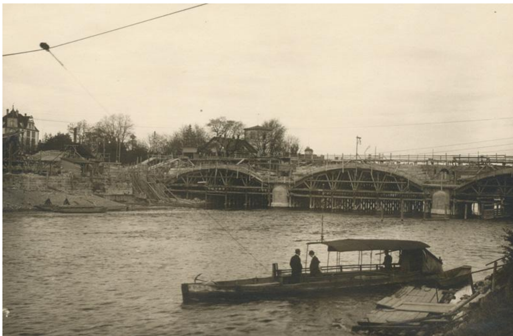
Bau der neuen Donaubrücke (Gänstorbrücke), 1912 (StA Ulm, G 7/2.1 Donaufrent)
