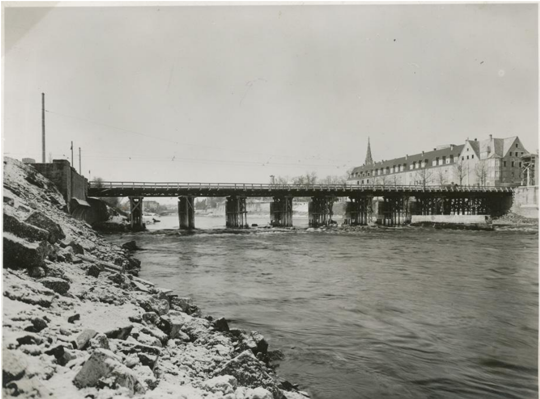
Provisorische Gänstorbrücke ca 1946 (StA Ulm, G 7/3.1 4600 Nr. 14)
