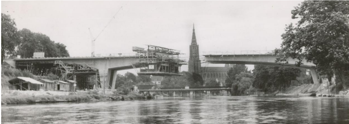
Die "Ringbrücke" im Bau April 1954 (StA Ulm, G 7/2.2 Donaufont)
