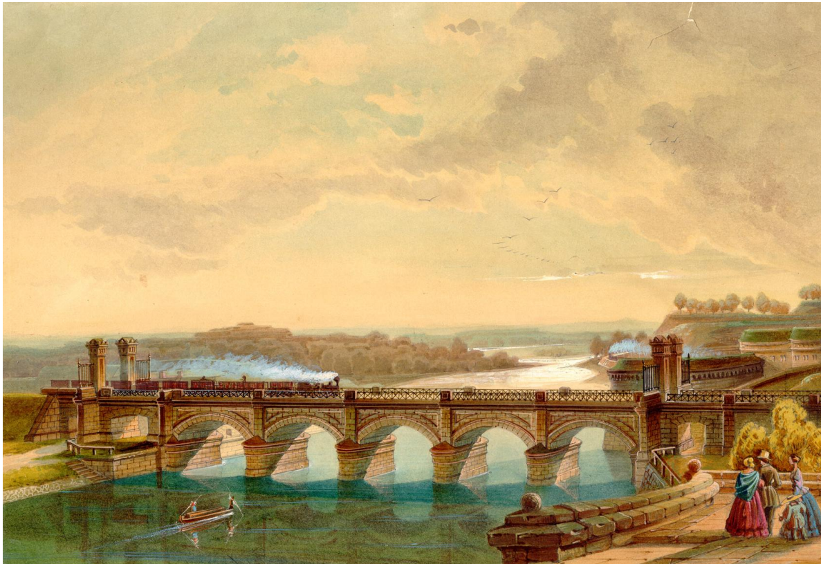
Ulmer Eisenbahnbrücke nach Westen gesehen, um 1870 (StA Ulm F 3 Ans. 354/1)
