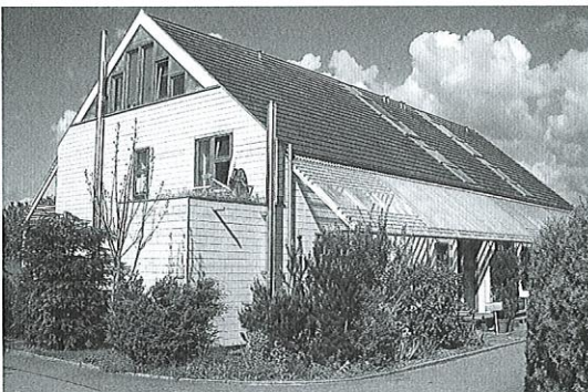
Reihenhäuser in Donaustetten mit 4 Einheiten
