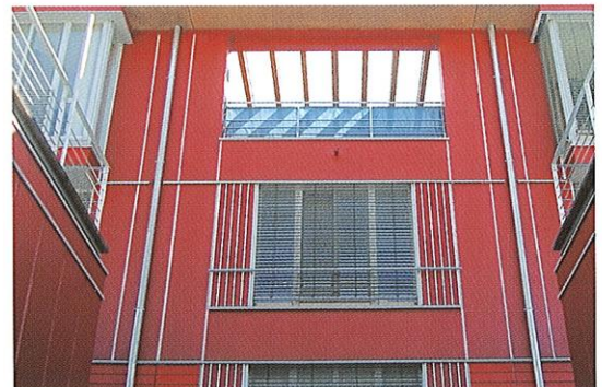
Zwischenflügel oben: glasbedeckte Terrasse des symmetrisch aufgebauten Hauses
