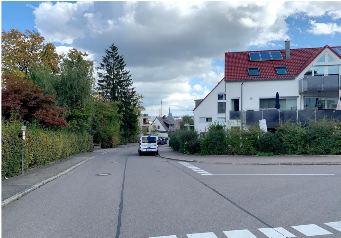
Abbildung 7: Blick von Südwesten, Straßenecke Maienweg/ Auf der Laue - Fernwirkung
