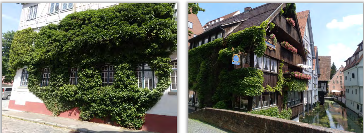
Abb. 28: Ausführungsbeispiele für Fassadenbegrünung in der Ulmer Innenstadt
