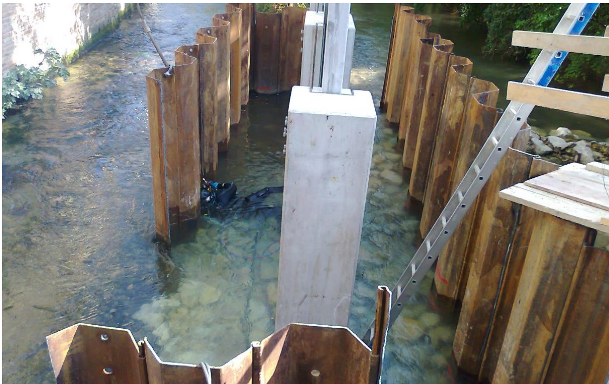
Hochwasserschutz Kleine Blau
