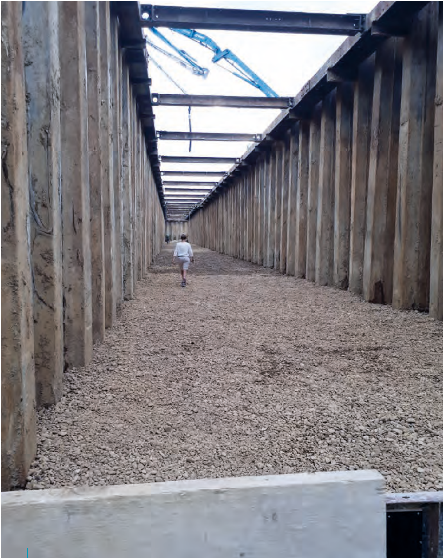
BG Brücke Anlieferung Rohre für regenrückhaltebecken Brücke © EBU
