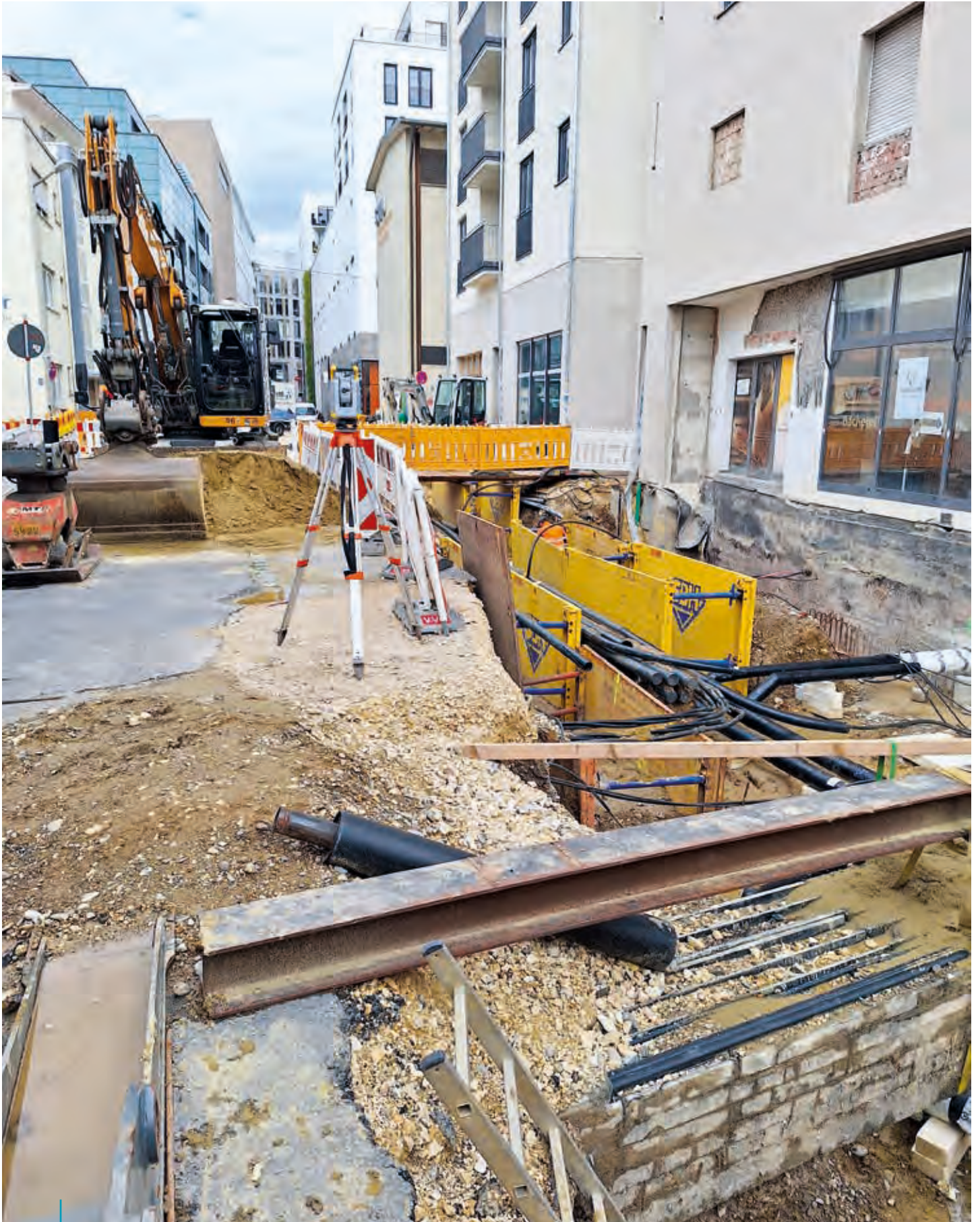
Wengenviertel Kanalerneuerung in geschlossener Bauweise © EBU
