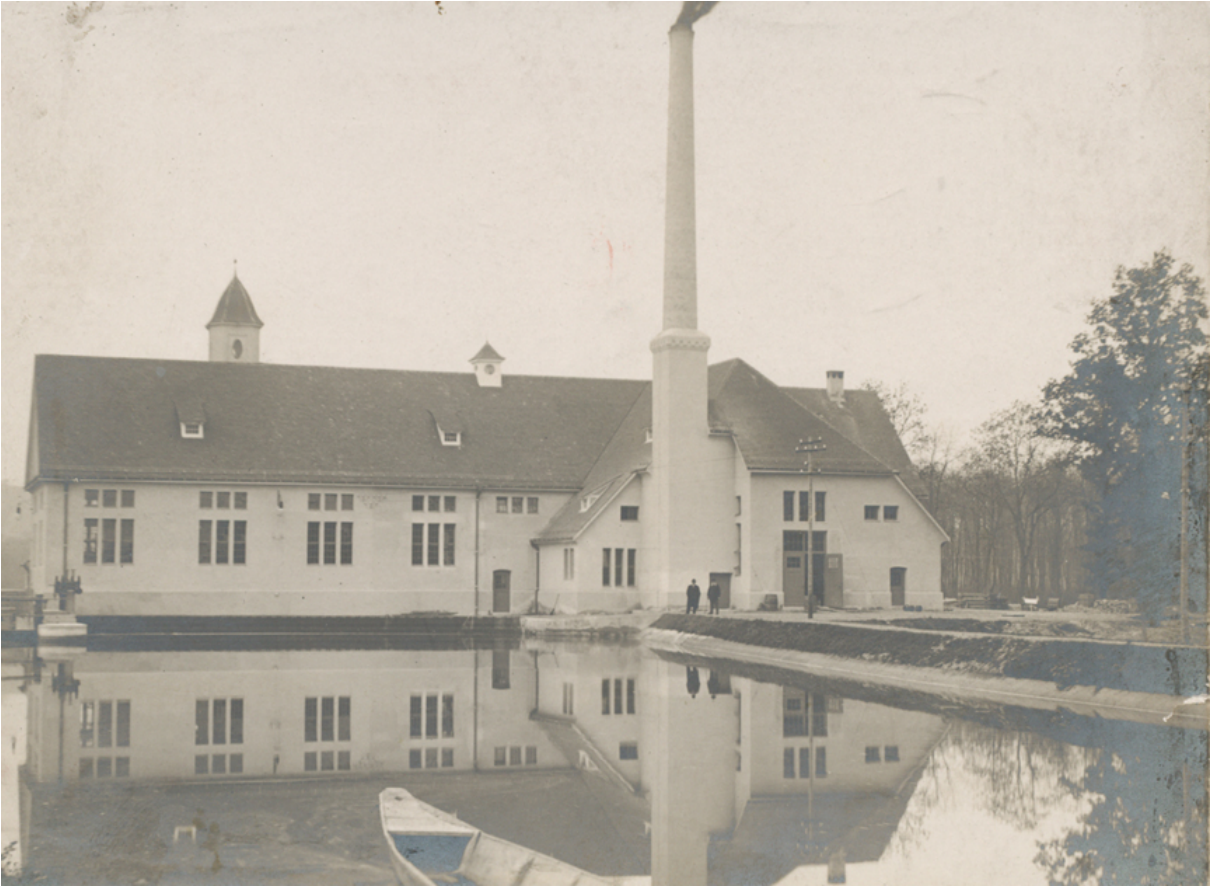
Material 3: Kraftwerk Wiblingen um 1910 (StA Ulm, G 7/2.1)
